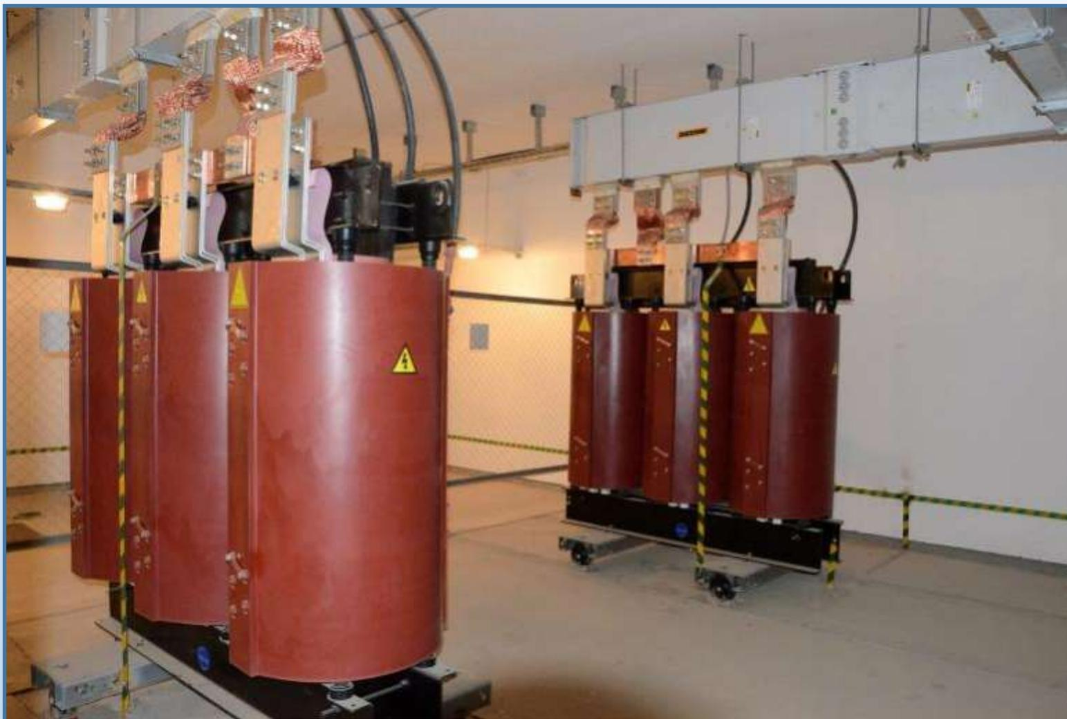
От распределительной подстанции электроэнергия подается на два трансформатора 6,3/0,4 кВ, каждый из которых может полностью обеспечить объект.
