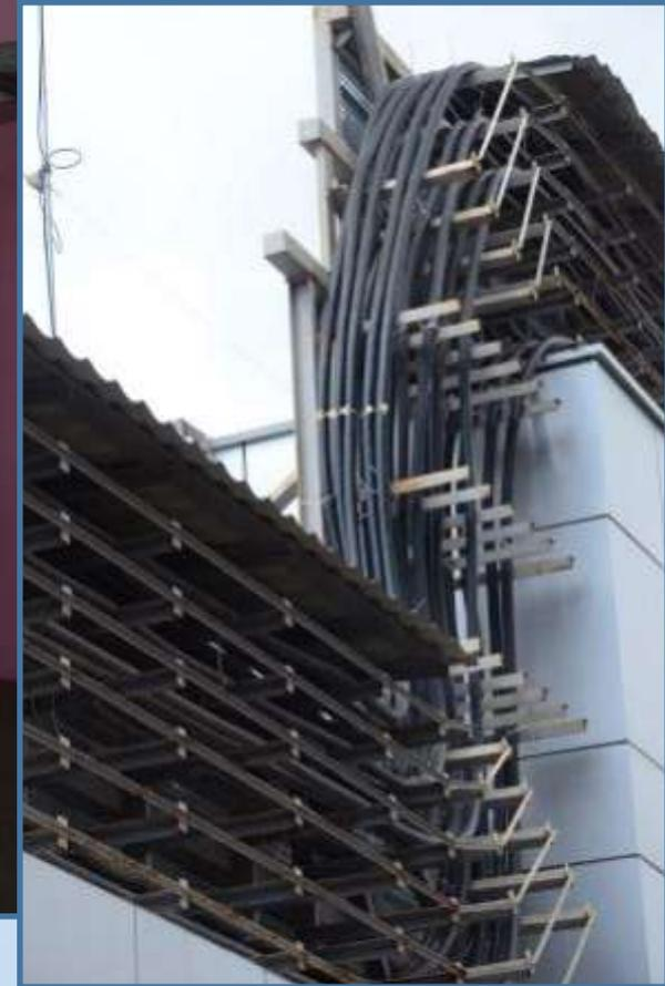
От группы трансформаторов электроэнергия передается в основное здание в две распределительные электрощитовые, расположенные в противоположных частях здания, по двум магистралям – воздушной и подземной.
