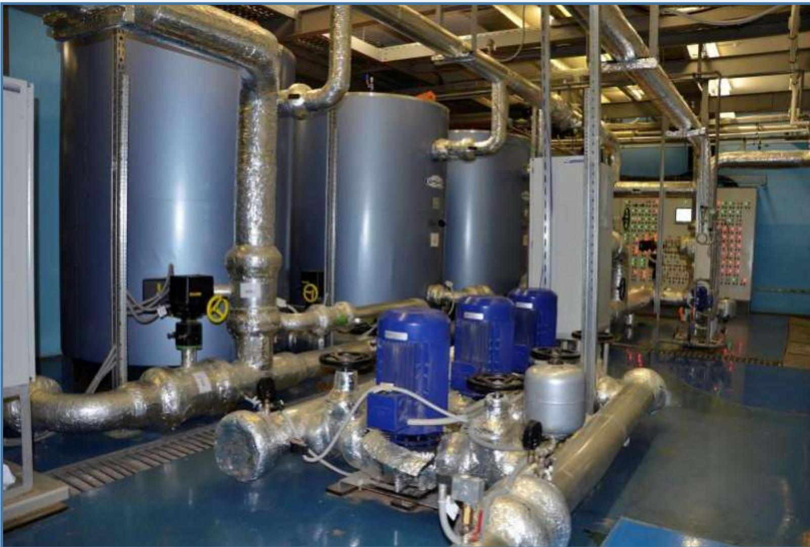
**И** буферные емкости с охлажденной водой, обеспечивающие соблюдение температурных режимов при переключении электропитания от централизованных на местные источники.
