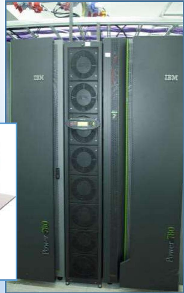
Для отвода тепла от серверов используется метод чередования «горячих» и «холодных» коридоров. Тепло, вырабатываемое серверами, выбрасывается в изолированный «горячий» коридор. Горячий воздух пропускается через межрядные кондиционеры, охлаждается, при необходимости увлажняется, и выбрасывается в «холодный» коридор.
