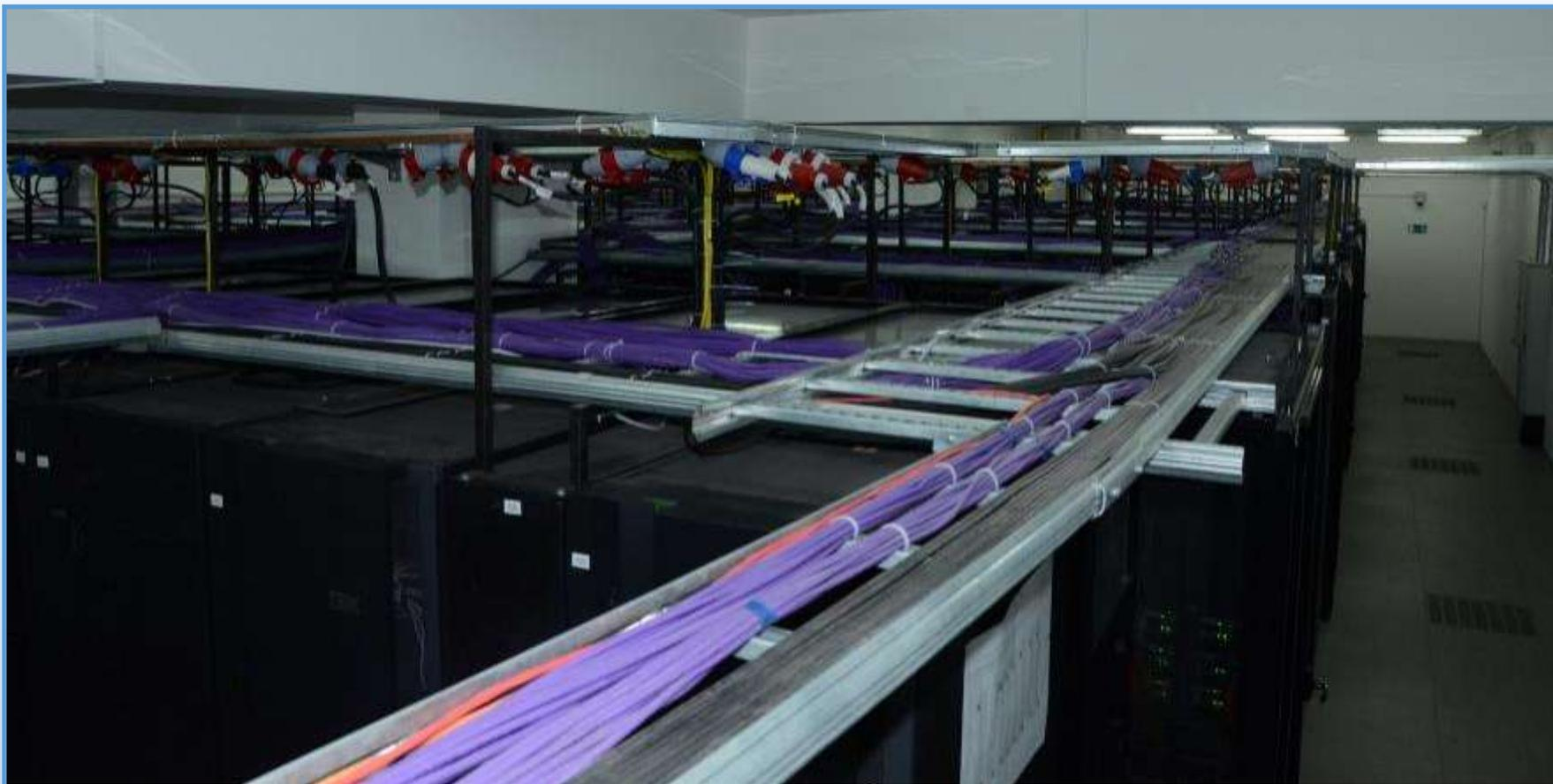
Структурированная кабельная система и линии системы электроснабжения проходят по кабель каналам, расположенным над серверными стойками.
