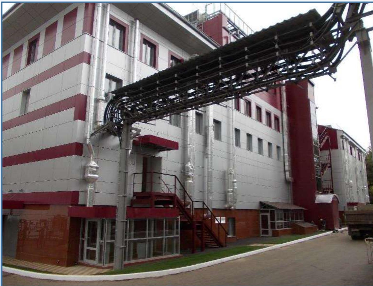
Все тяжелое инженерное и вычислительное оборудование установлено на нижних этажах главного здания. На верхних - размещены офисные помещения и часть системы охлаждения.
