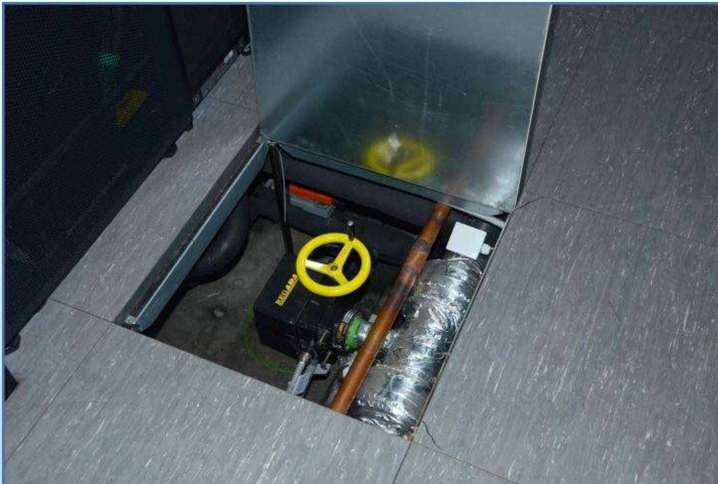
Все серверные помещения оснащены фальшполом, под которым размещены инженерные магистрали систем водоснабжения и охлаждения.
