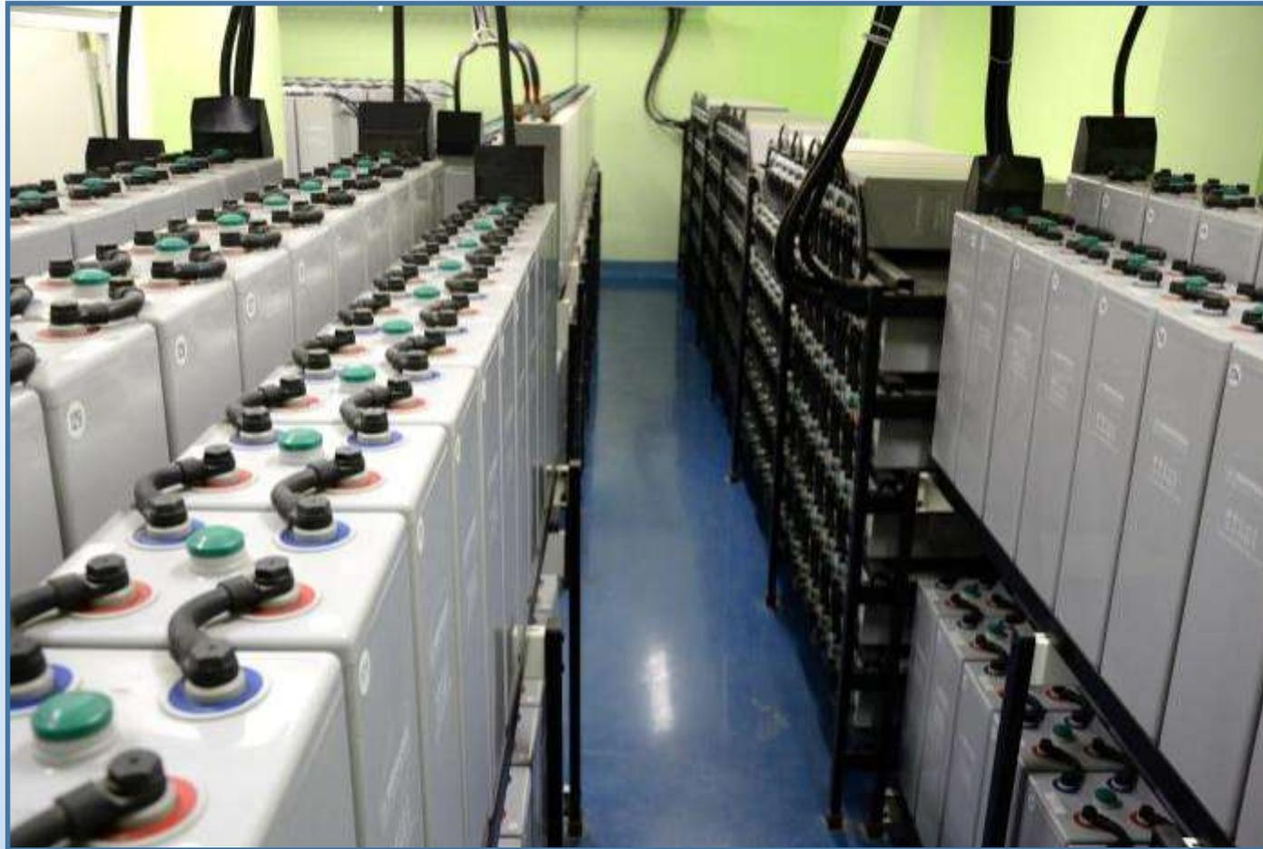
Для бесперебойной работы энергопотребляющего оборудования, в случае глобальной аварии на сетях внешнего электропитания, в дата-центре установлены две аккумуляторные батареи, каждая из которых способна поддерживать функционирование дата-центра при полной нагрузке в течении 15 минут – срока, необходимого для запуска системы внутреннего электроснабжения.
