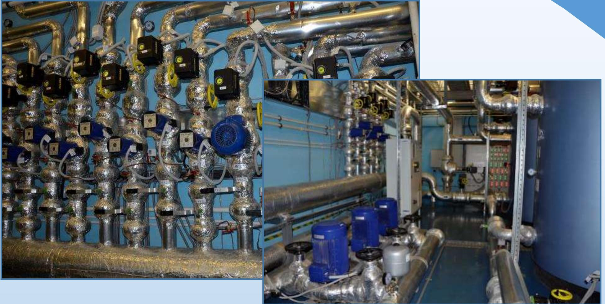
Там находятся теплообменники, которые позволяют перейти от контура с водой на контур с этиленгликолем. Здесь же расположены распределяющие гребенки, управляющие насосы
