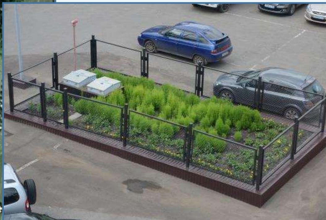
Два разнесенных друг от друга подземных топливохранилища содержат запас дизельного топлива в сумме достаточный для 10 суток работы ЦОДа с полной нагрузкой.
