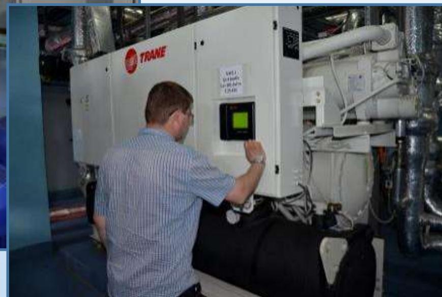
Охлаждение этиленгликоля обеспечивают две группы холодильных машин, расположенных на самом верхнем, техническом, этаже здания.
