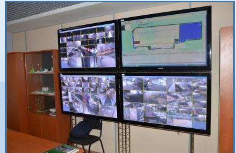
Так, например, чтобы попасть в главный серверный зал надо пройти семь рубежей контроля, последний из которых – биометрический. В распоряжении службы охраны дата-центра около полутора сотен видеокамер и более двухсот датчиков различного назначения – датчики движения, дверные датчики и датчики пересечения периметра, а так же система оповещения.
